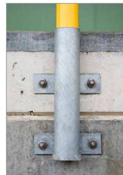
Befestigung mit Einsteckhülse
