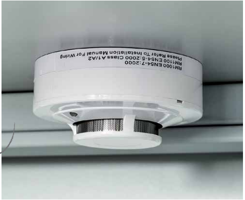
Warn-/Brandunterdrückungssystem: Hochwertiges 3-stufiges Warn-/Brandunterdrückungssystem im Schrankinnenraum löst im Brandfall automatisch aus.
