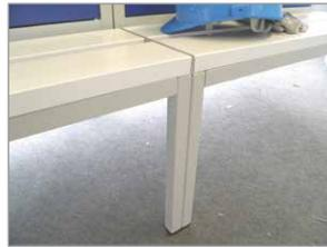
benachbarte Stützen ohne Zwischenraum, vorteilhaft zur Bodenreinigung
